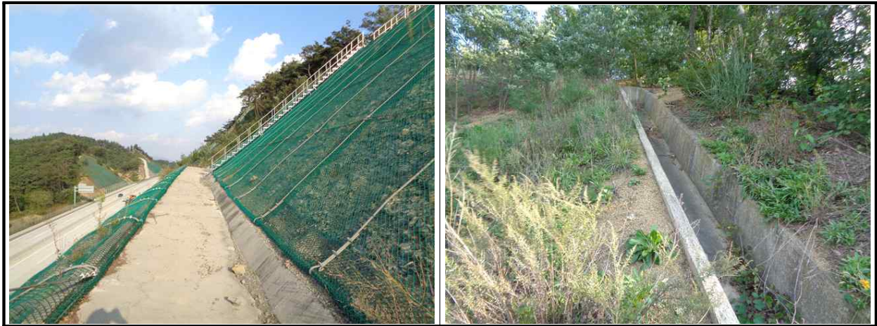
【그림 46.3.3】 배수시설 전경
