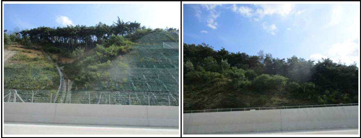
【그림 46.3.1】 상부자연사면 전경
